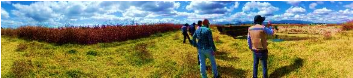
FOTOGRAFÍA 16: PANORAMA DEL SOCAVÓN DURANTE LA INSPECCIÓN PRELIMINAR.
