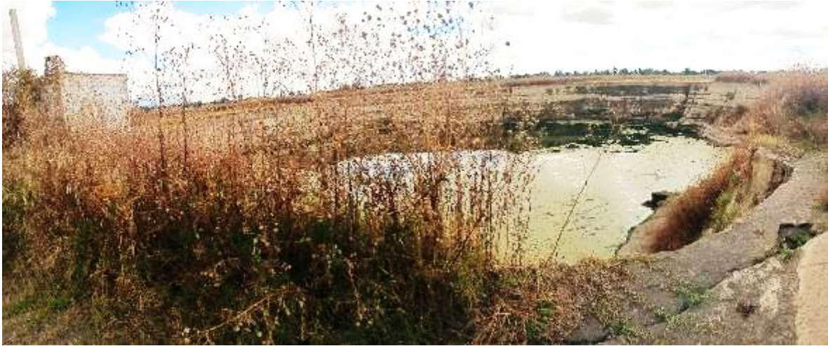
FOTOGRAFÍA 13: VISTA DEL SOCAVÓN DESDE LA CASA QUE SE CAYÓ.
