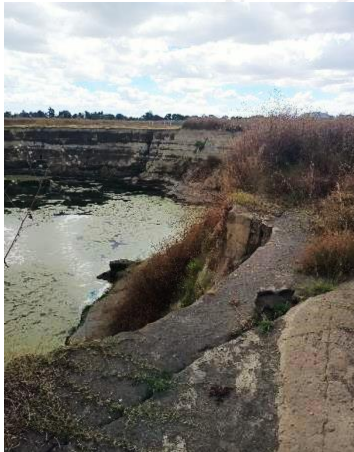
FOTOGRAFÍA 14: ZONA DE MAYOR RIESGO.
